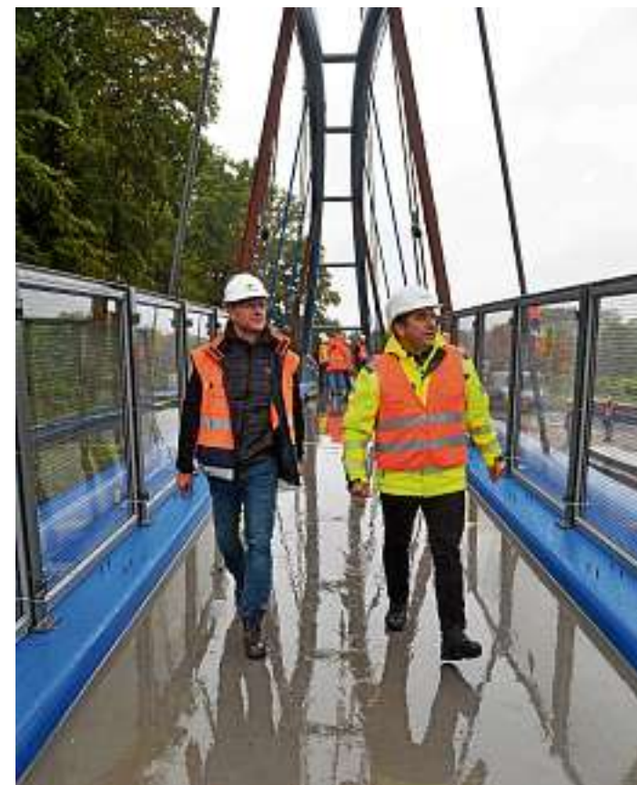
Noch wartet das Bauwerk hier am Boden auf den Einhub. Da kann man schon einmal einen Spaziergang wagen.
