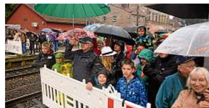
Trotz strömenden Regens schauten viele Eichsfelder zu, als am Freitag die neue Brücke an ihren zukünftigen Platz bugsiert wurde.
