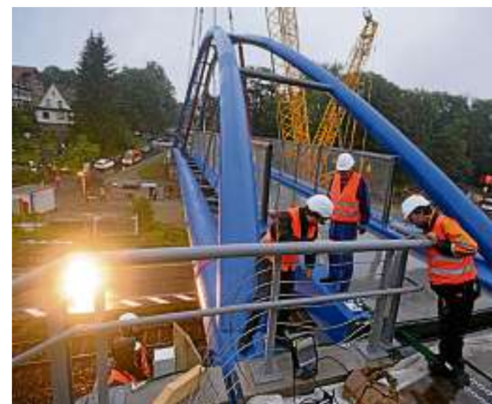
Genau wurde kontrolliert, ob die Brücke punktgenau auf den Widerlagern aufgesetzt wurde. Es hat funktioniert.
