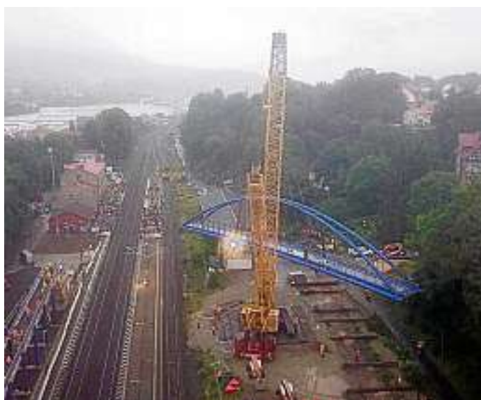
So sah der Einhub aus der Luft aus. Trübes Wetter, Dauerregen, aber ein erfolgreich verlaufenes Spektakel. Foto: Stadt Heiligenstadt
