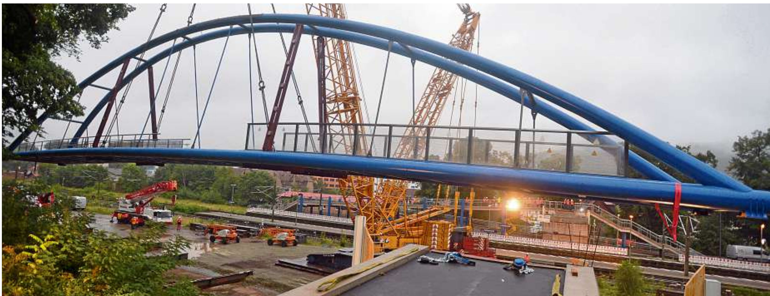
61 Meter Spannweite hat die 225 Tonnen schwere Stahlbogenbrücke. Ab November ist sie für Fußgänger und Radfahrer benutzbar. Sie verbindet das Hohe Rott mit der Innenstadt.
